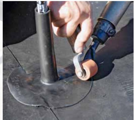
nische Lagesicherung verzichtet werden. Der einseitig klebefreie Schweißrand der Bahnen ermöglicht einen homogenen Nahtschluss. Die Längsnähte wurden mit einem Schweißautomaten verschweißt und anschließend mit einer herstellereigenen Flüssigfolie nahtversiegelt, die Stöße mit Streifen abgedeckt und mit einem Handföhn heißluftverschweißt. Die homogen verschweißte Fläche reicht von Attika zu Attika bzw. zum auf-
