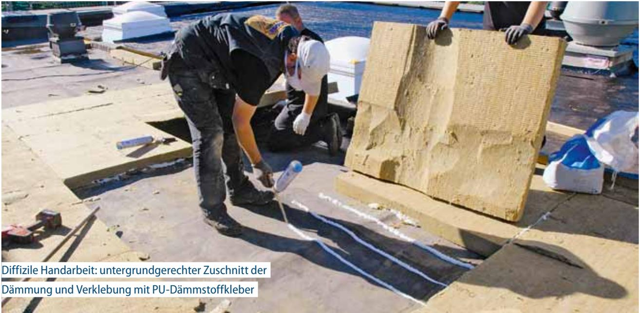
Diffizile Handarbeit: untergrundgerechter Zuschnitt der Dämmung und Verklebung mit PU-Dämmstoffkleber
