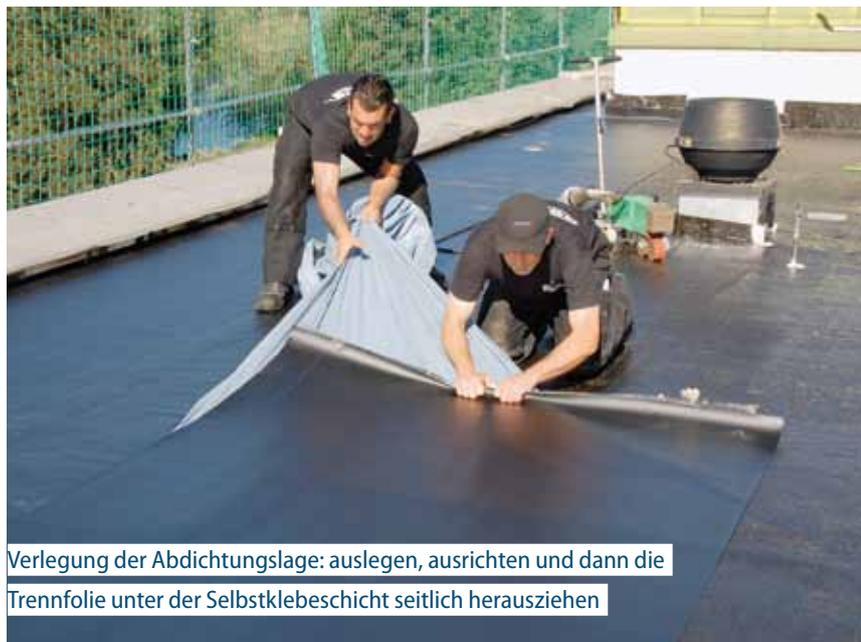
Verlegung der Abdichtungslage: auslegen, ausrichten und dann die Trennfolie unter der Selbstklebeschicht seitlich herausziehen
